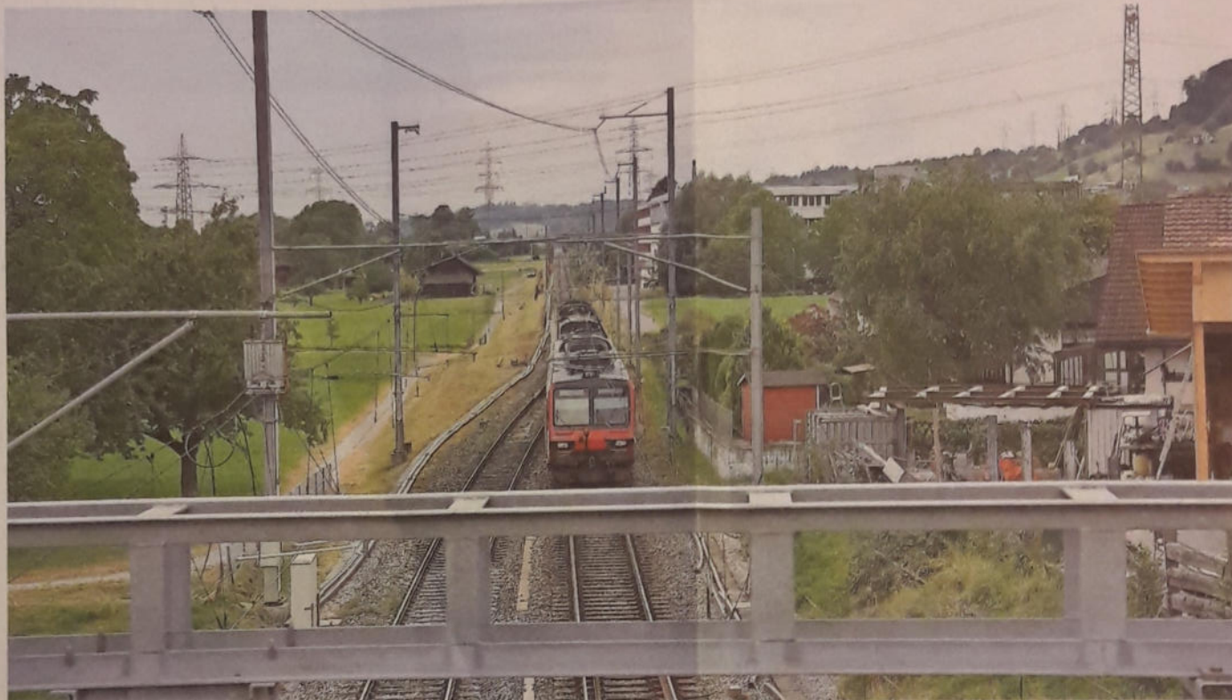
Hier verkehren bald doppelt so viele Züge: Mit dem jüngsten Urteil erhält der Doppelspurausbau grünes Licht.
